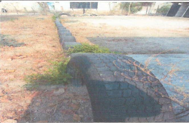
Foto 3: Mejoramiento muro de contención
