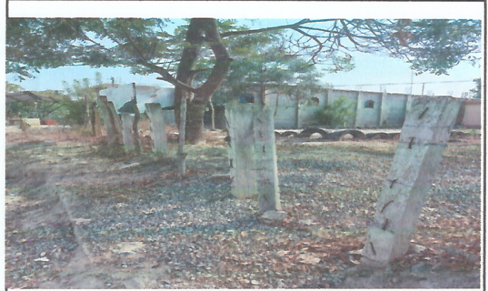
Foto 2: mejoramiento a muro perimetral
