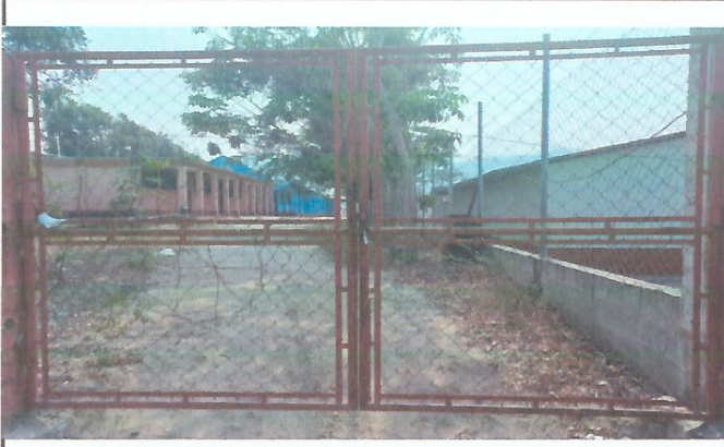
Foto 1: Mejoramiento a portón de ingreso
